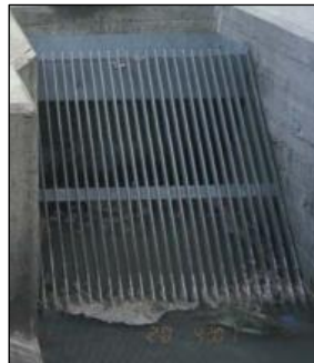
Gambar 2.3 Coarse Screen dengan Pembersihan secara Manual
