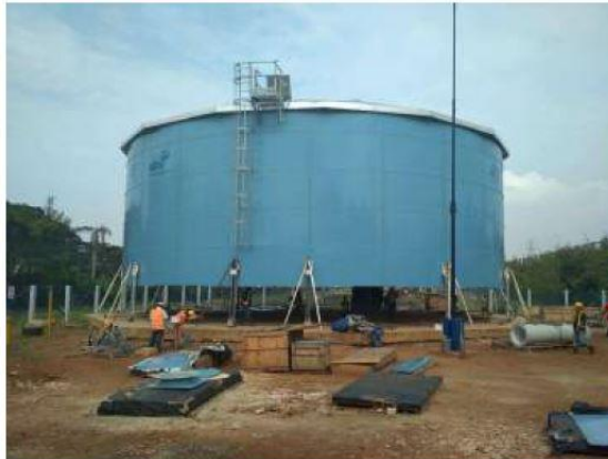
Gambar 2.23 Reservoar Tangki Baja
