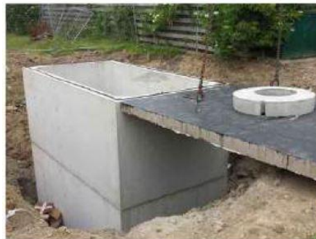
Gambar 2.24 Reservoar Beton Cor
