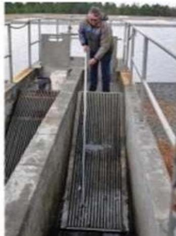
Gambar 2.3. Pembersihan Bar Screen Manual di Lapangan
