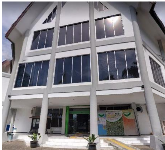
Gambar 2.81 Struktur gedung perpustakaan Sumber : Hasil Pengamatan Lapangan, 2021
