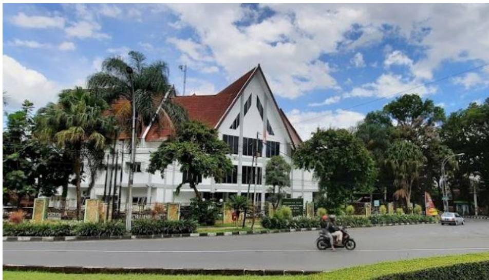
Gambar 2.71 Tampilan fasad bangunan Sumber : Hasil Pengamatan Lapangan, 2021
