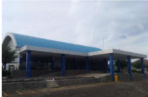
Gambar 1.5 Bandar Udara Harun Thohir Bawean Sumber: Dokumen Pribadi
