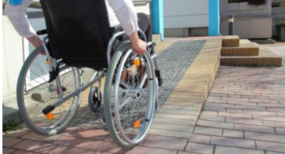
Gambar 5. 10 Ramp bagi penyandang Disabilitas
