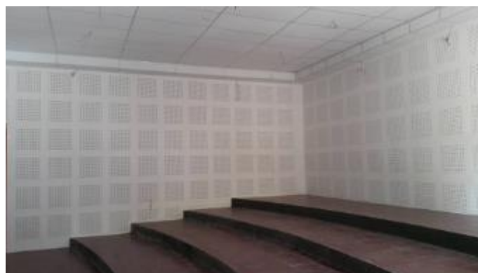
Gambar 5. 21 Mineral Wool dengan Perforasi Sebagai Penyerap Lunak Sumber: Analisis Pribadi, 2022
