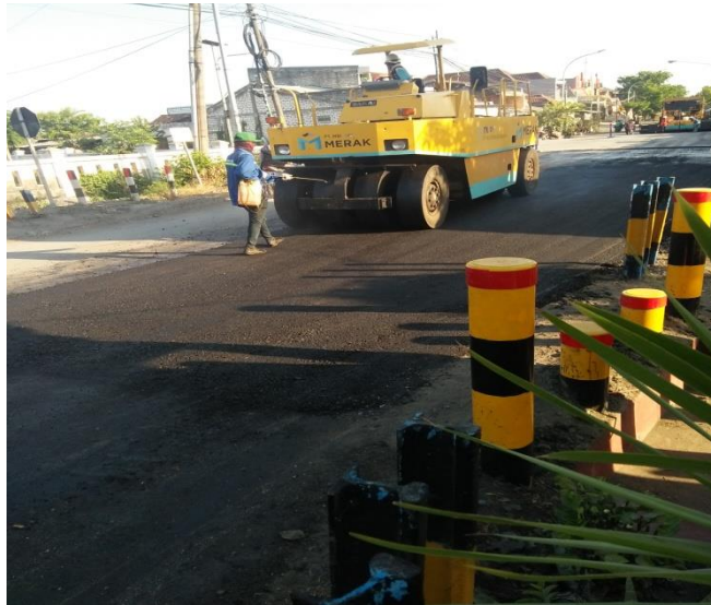
Gambar 3.15 Pemadatan Aspal
