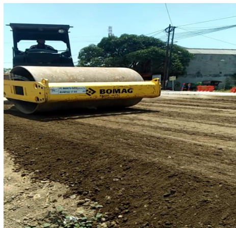
Gambar 3.11 Pemadatan Tanah
