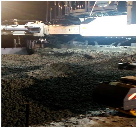
Gambar 3.4 Pemadatan Beton
