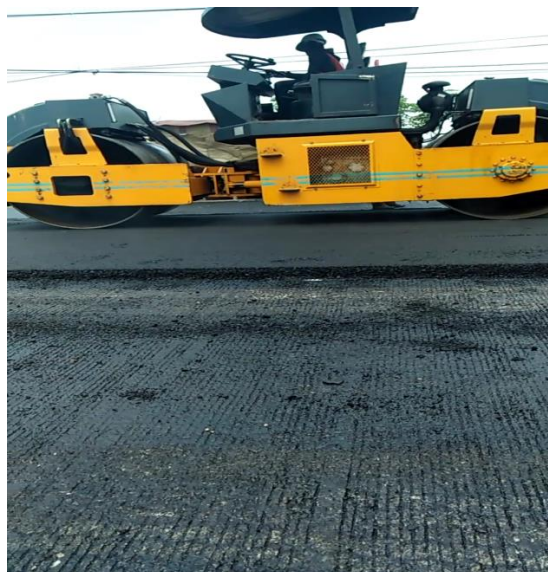
Gambar 3.14 Pemadatan Aspal
