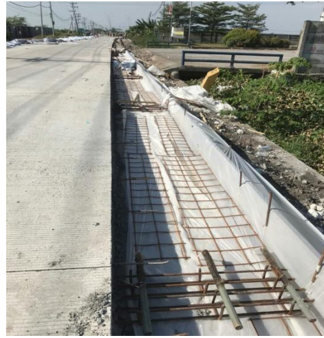
Gambar 3.17 Pengecoran Manual
