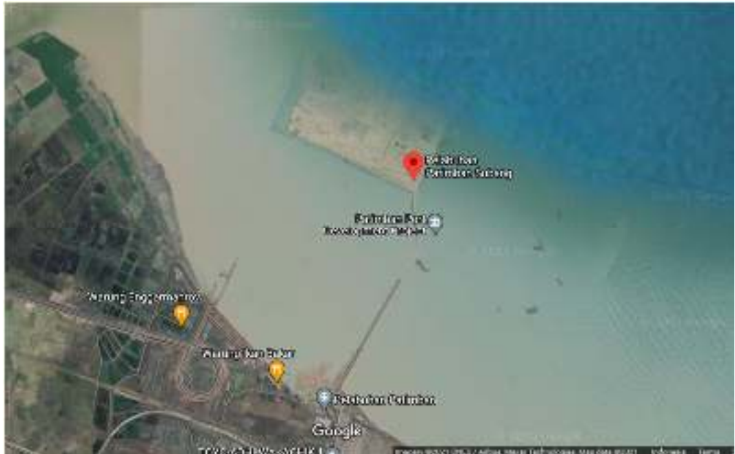
Gambar 1. Lokasi Proyek Pembangunan Pelabuhan Patimban Paket 1
