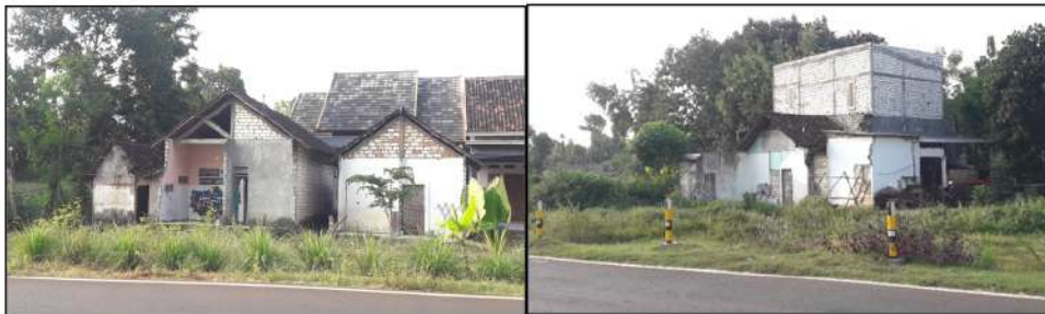
Gambar 5. Bagian rumah yang tergusur untuk pembangunan Jalan Lingkar Selatan ( Ring Road )
