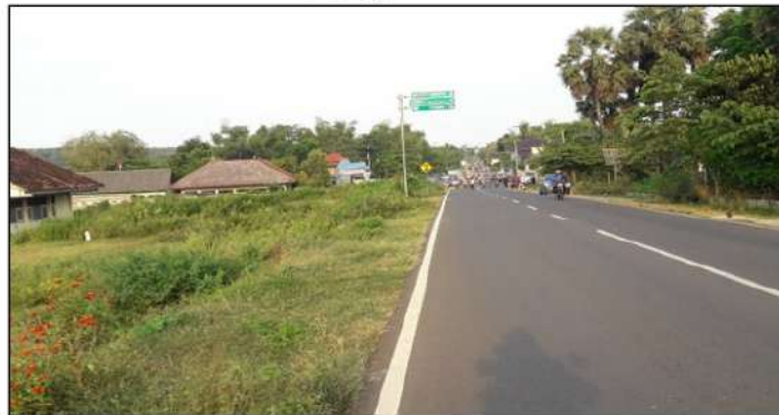
Gambar 3. Salah Satu Badan Jalan Lingkar Selatan ( Ring Road ) Yang Belum Terbangun
