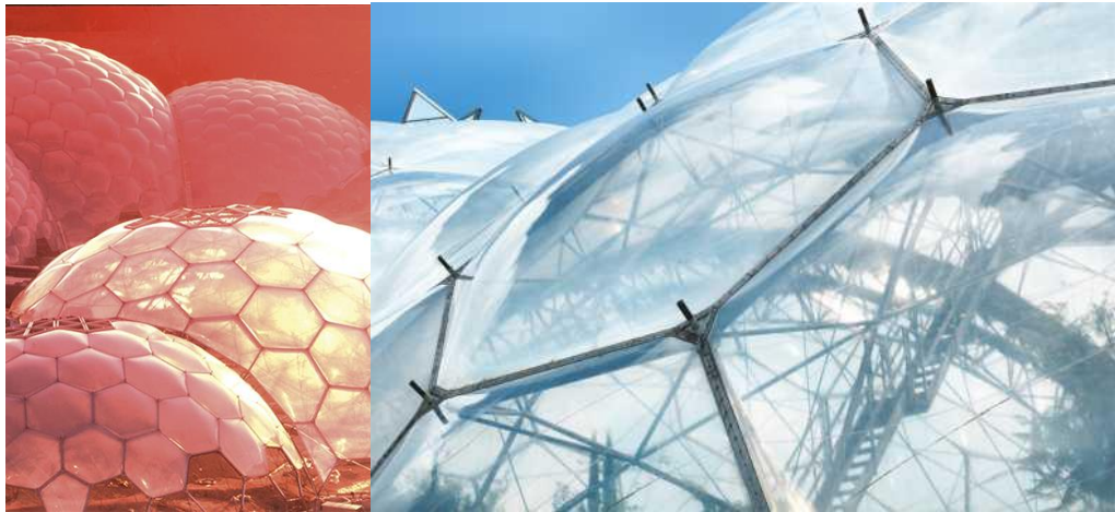
Gambar 2.32 Struktur Hex-Tri-Hex dan detail lapisan bantalan EFTFE Sumber : Google, 2020
