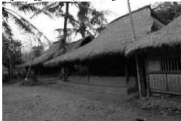
Gambar 2.30. Tampak Rumah Bale Tani
