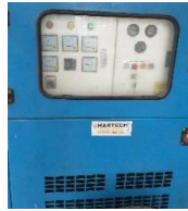
Gambar 26 Genset Sumber : Dokumen Pribadi
