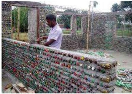
Gambar 2. Ecobrick untuk pengganti bata pada bangunan
