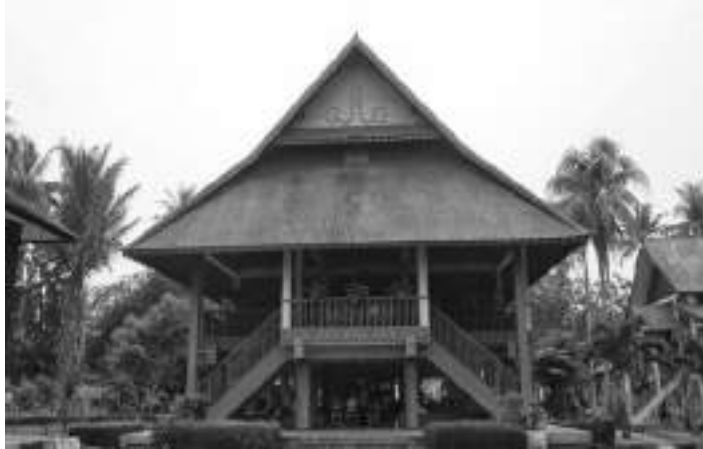
Gambar 2.37. Tampak Rumah Walewangko
