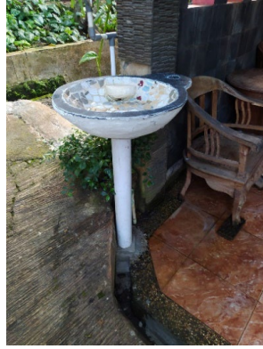
Gambar 4 Tiang dasar menggunakan Paralon sebelum diberi motif relief kayu. Sumber : Dokumen Pribadi
