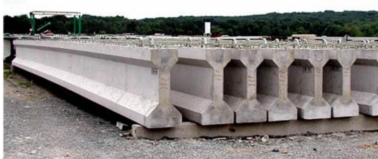
Gambar 2.14 Balok dukung girder
